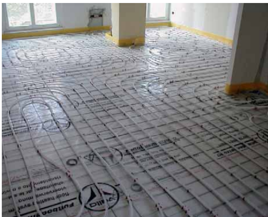
Una fase della posa dell'impianto di riscaldamento radiante a pavimento.
